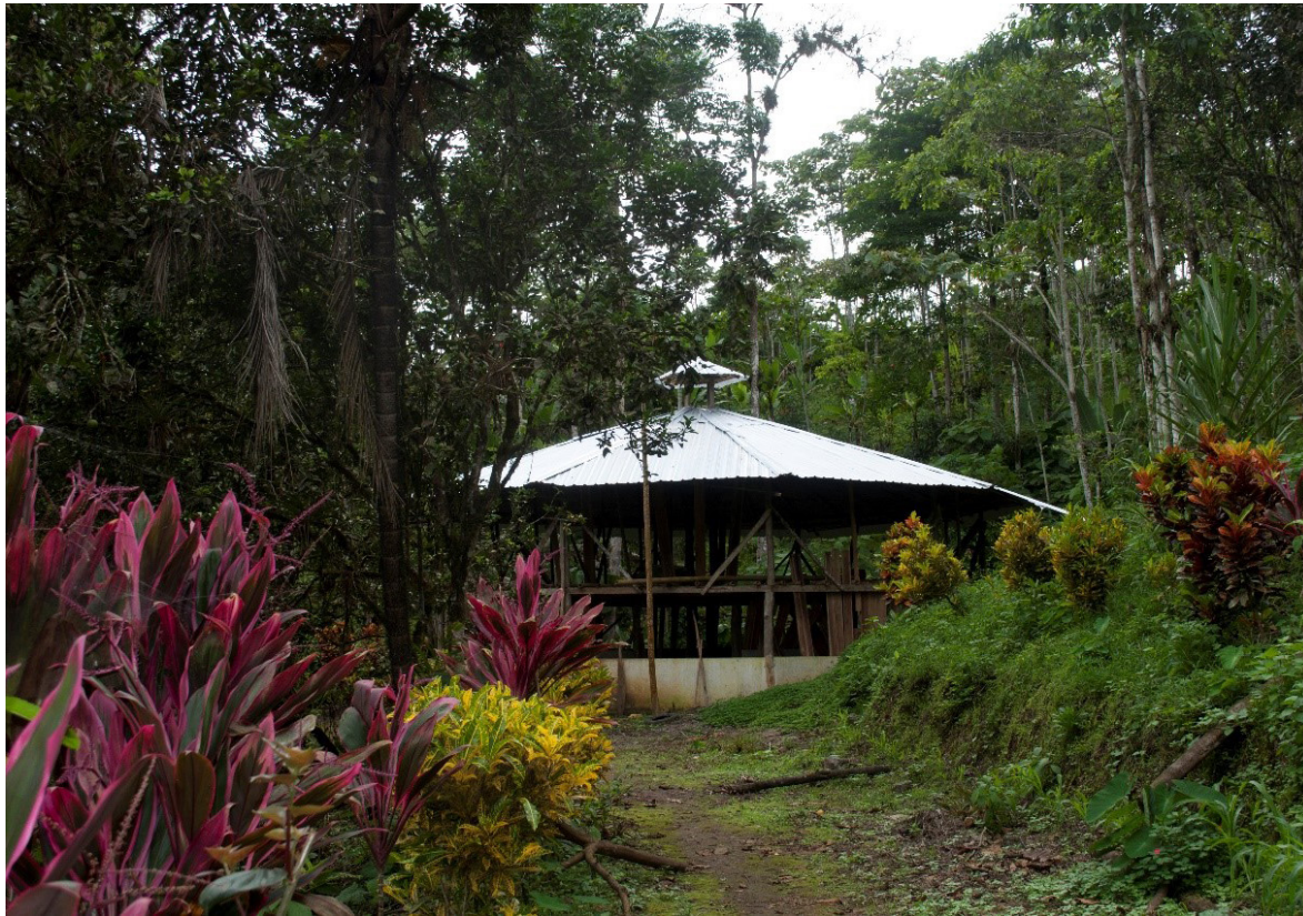
Fotografía 8. Etapa inicial de la estructura del Museo. Autor Freddy Paredes Avilés - 2018.
